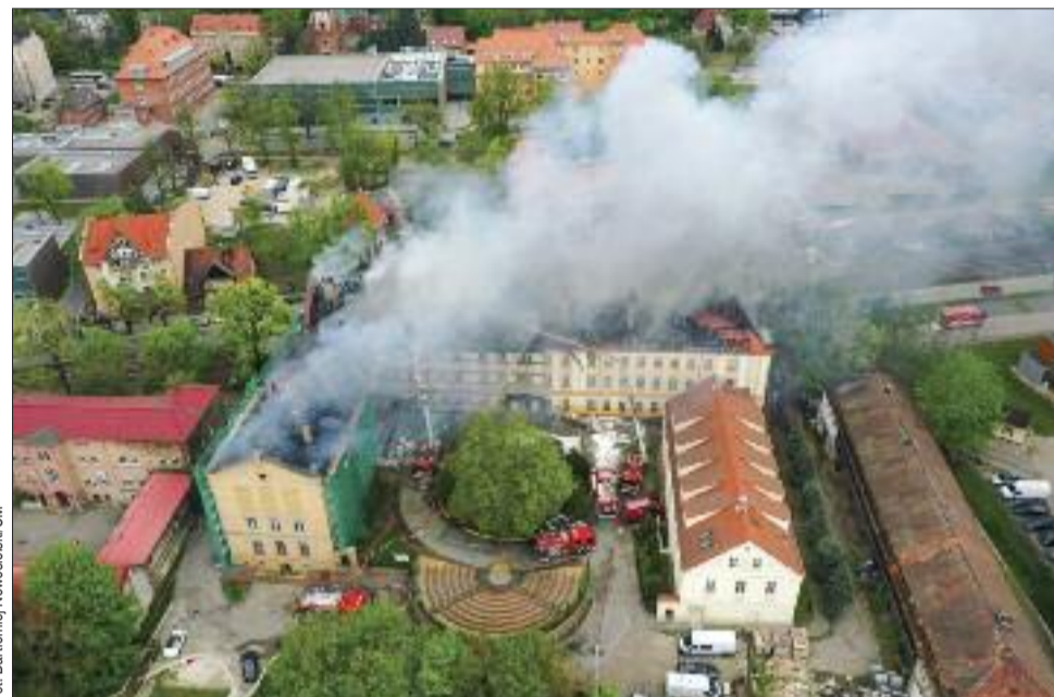
Stopień zniszczenia budynków AJP najlepiej jest widoczny z góry
